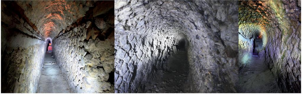
Fig. 5a - 5b - 5c. Il rivestimento in *opus reticulatum* nel condotto. (Foto di M. De Menna e R. Iezzi)
